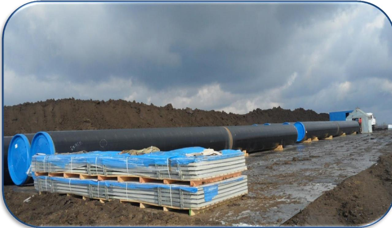
При строительстве газопровода диаметром 1420 мм одной из главных задач было обеспечить сохранность грунта при проведении работ, а также обеспечить устойчивость спецтехники на черноземных грунтах со слабым основанием.
