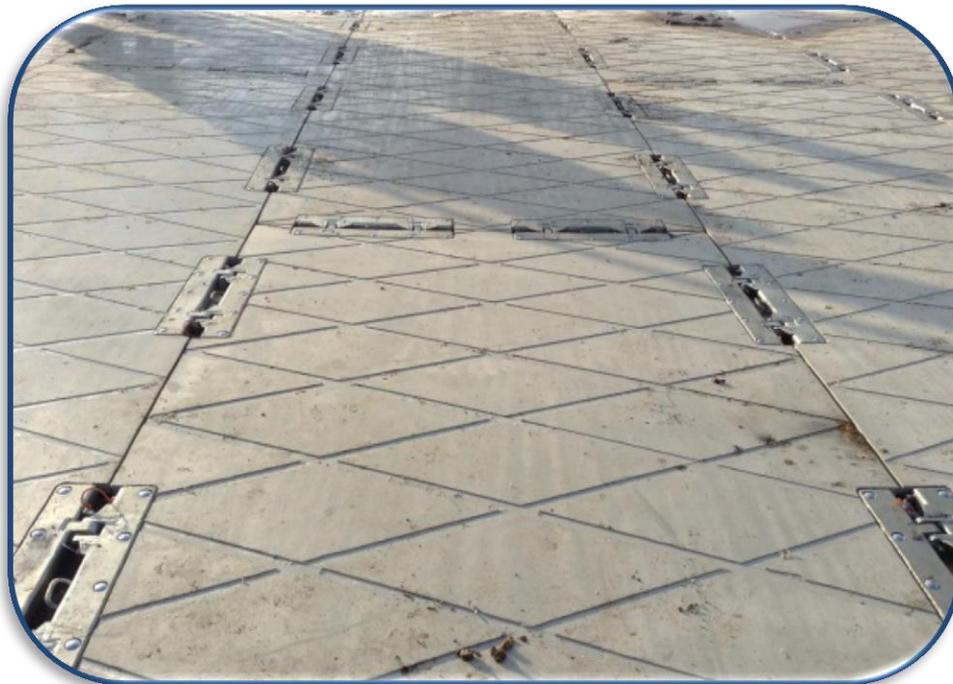
В процессе соединения МДП, подтверждена технологичность сборки, отсутствие необходимости в использовании инструментов и вспомогательных приспособлений для скрепления плит между собой. Среднее время монтажа одного МДП не превысило 3 мин.
